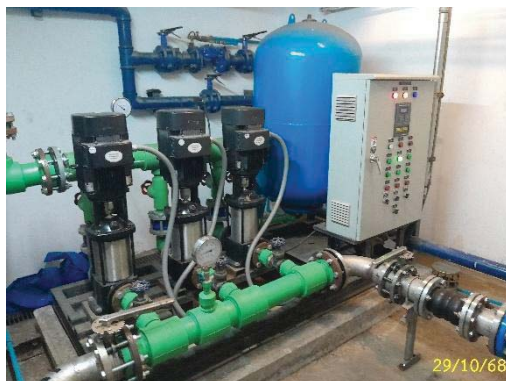
เครื่องปั๊มน้ำสำหรับอุปโภค-บริโภค อาคาร B
