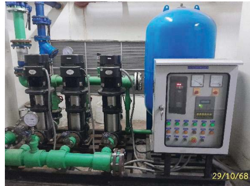
เครื่องปั้มน้ำสำหรับอุปโภค-บริโภค อาคาร A
